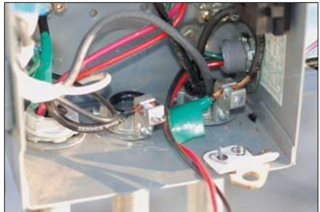
**Photo 6. Bonding bushing on 500 VDC conduits**
