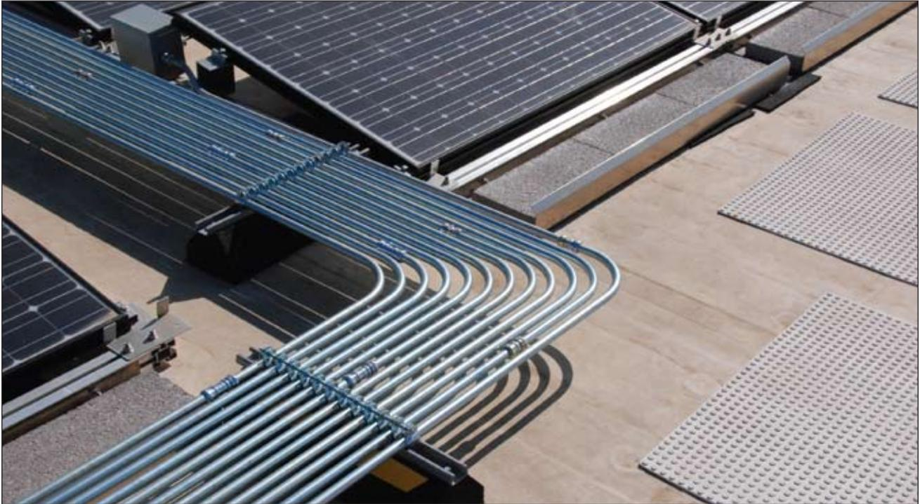
**Photo 9. Conduits on hot roof**
